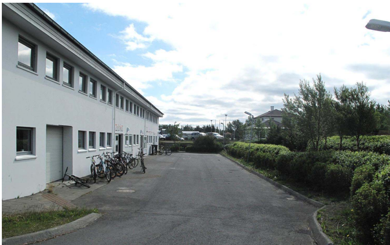
Mynd 7. Suðurhlið Pakkhússins
