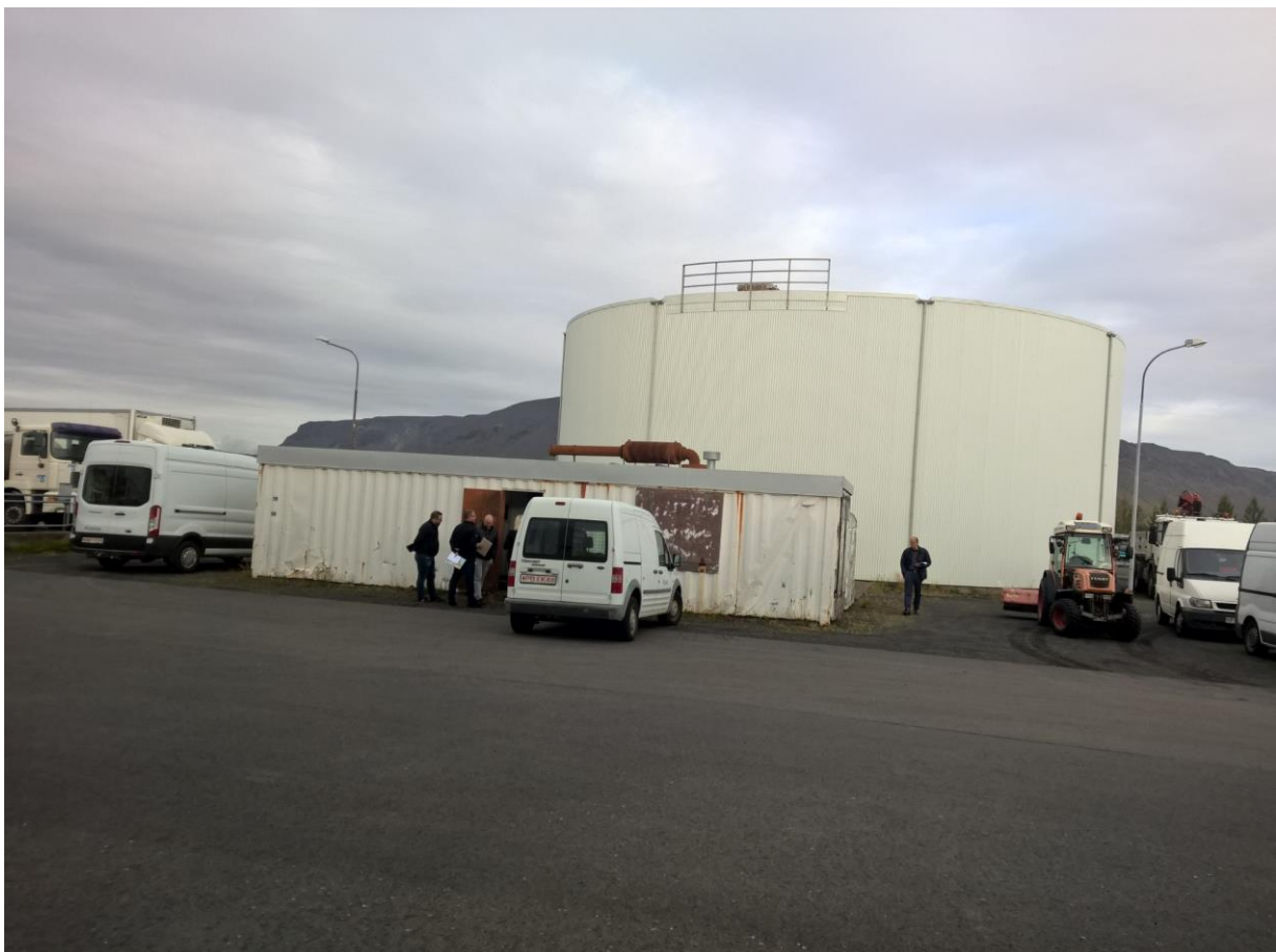
Mynd 2.2 Varaflsstöð í bráðabirgðaaðstöðu og núverandi heitavatnsgeymir. Mynd: Verkís.
