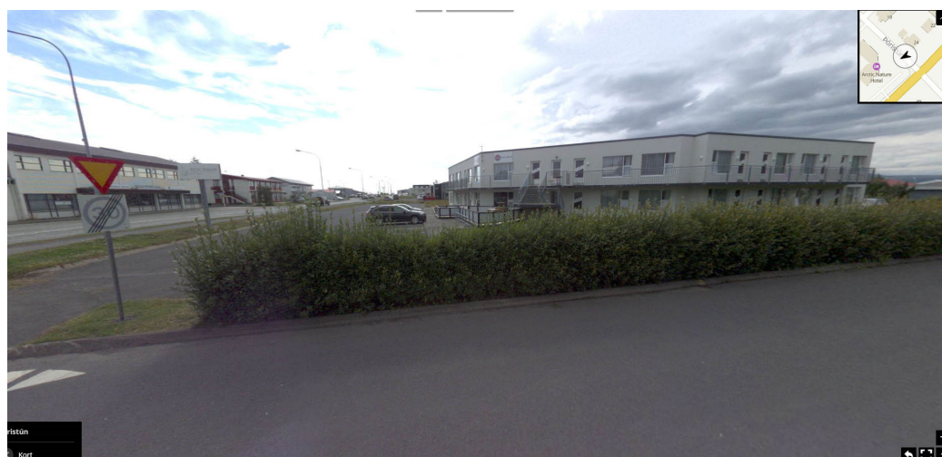
mynd 9. Séð til suðurs, Eyravegur t.v. og hús á lóð 26 t.h.
